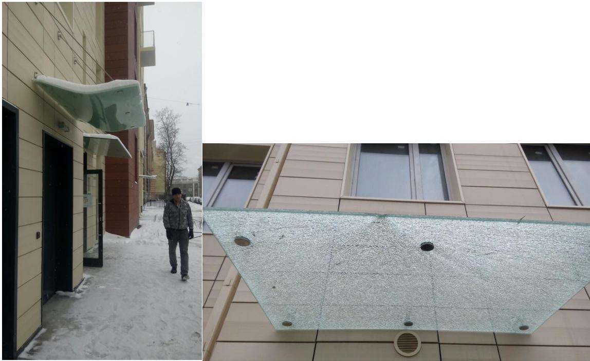
46. Ремонт фасада помещения ГРЩ после аварийного наезда снегоуборочного трактора при гололеде. Демонтаж разбитых фасадных плит и погнутого каркаса крепления плит и монтаж нового каркаса и фасадных плит.
